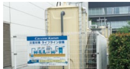
研究開発センター・本社に設置した「地下水膜ろ過システム」
